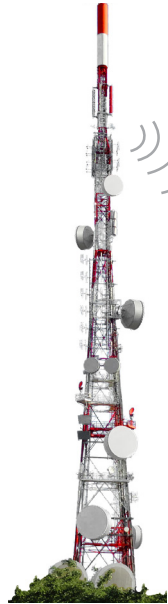
Antenna televisiva trasmittente
