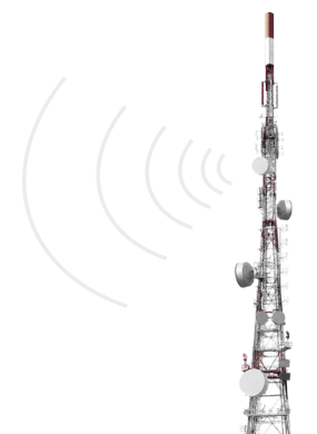
Antenne trasmittenti direzione B
