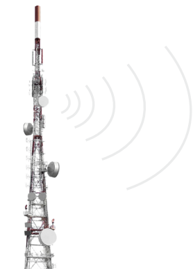
Antenne trasmettenti direzione A
