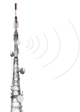
Antenne trasmittenti direzione A
