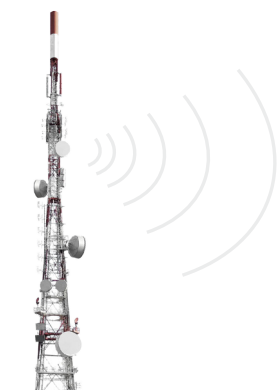
Antenne trasmettenti direzione A
